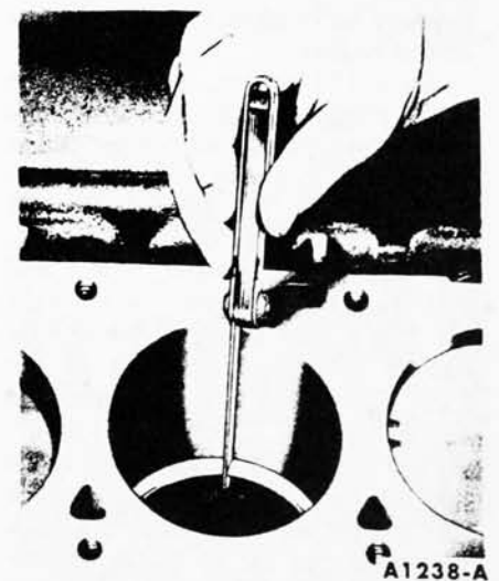
FIG. 19—Piston Ring Gap
